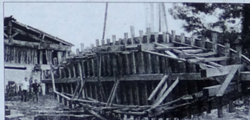
Les charpentiers mettent des cales. PHOTOS CHANTIERS TRAMASSET
