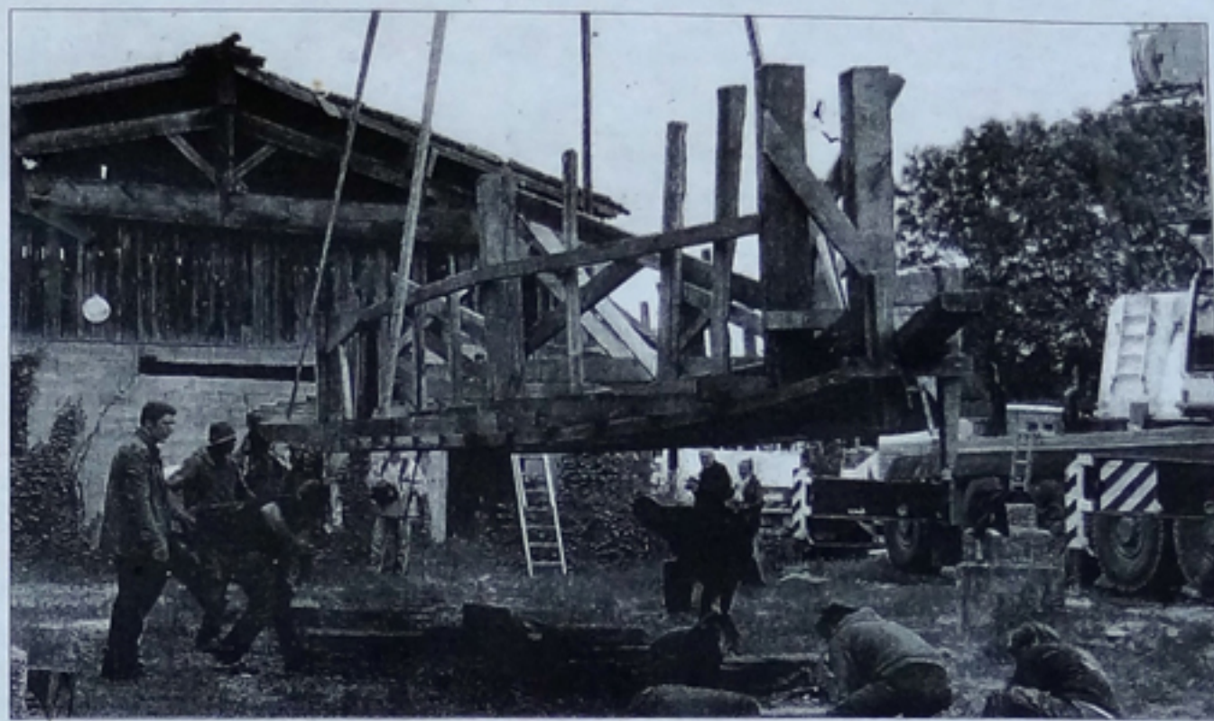
Les charpentiers mettent des cales. PHOTOS CHANTIERS TRAMASSET
