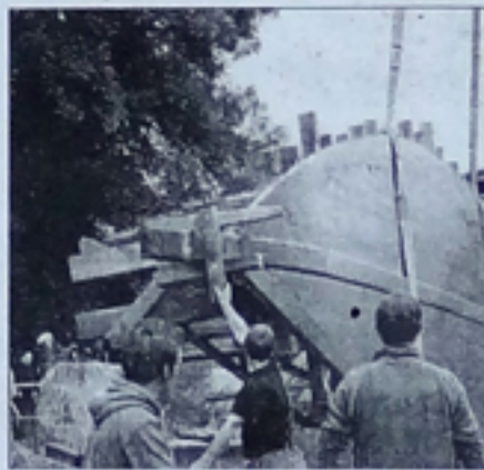
Les charpentiers mettent des cales. PHOTOS CHANTIERS TRAMASSET
